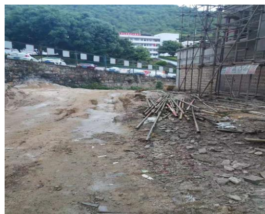
项目区道路现状
