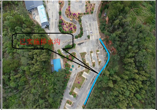
排水沟实施现状
