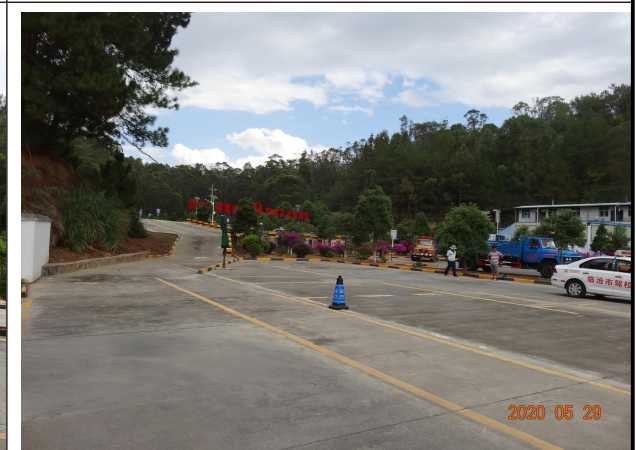
道路及硬化场地区现状
