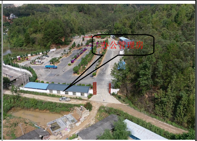
办公管理房建设现状
