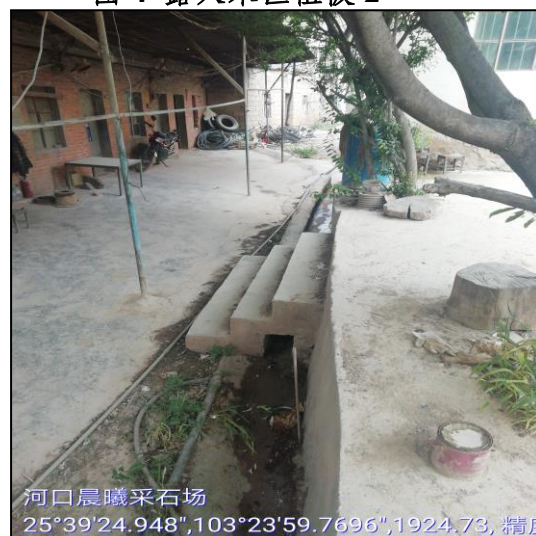
图 6 办公生活区排水沟
