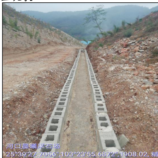
图 2 道路区砖砌排水沟 2
