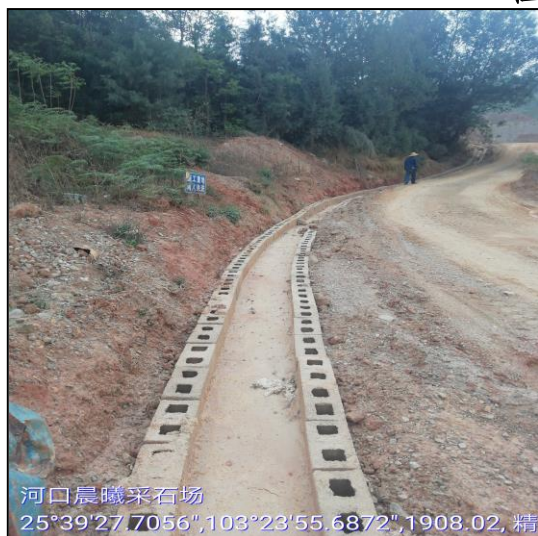
图 1 道路区砖砌排水沟 1
