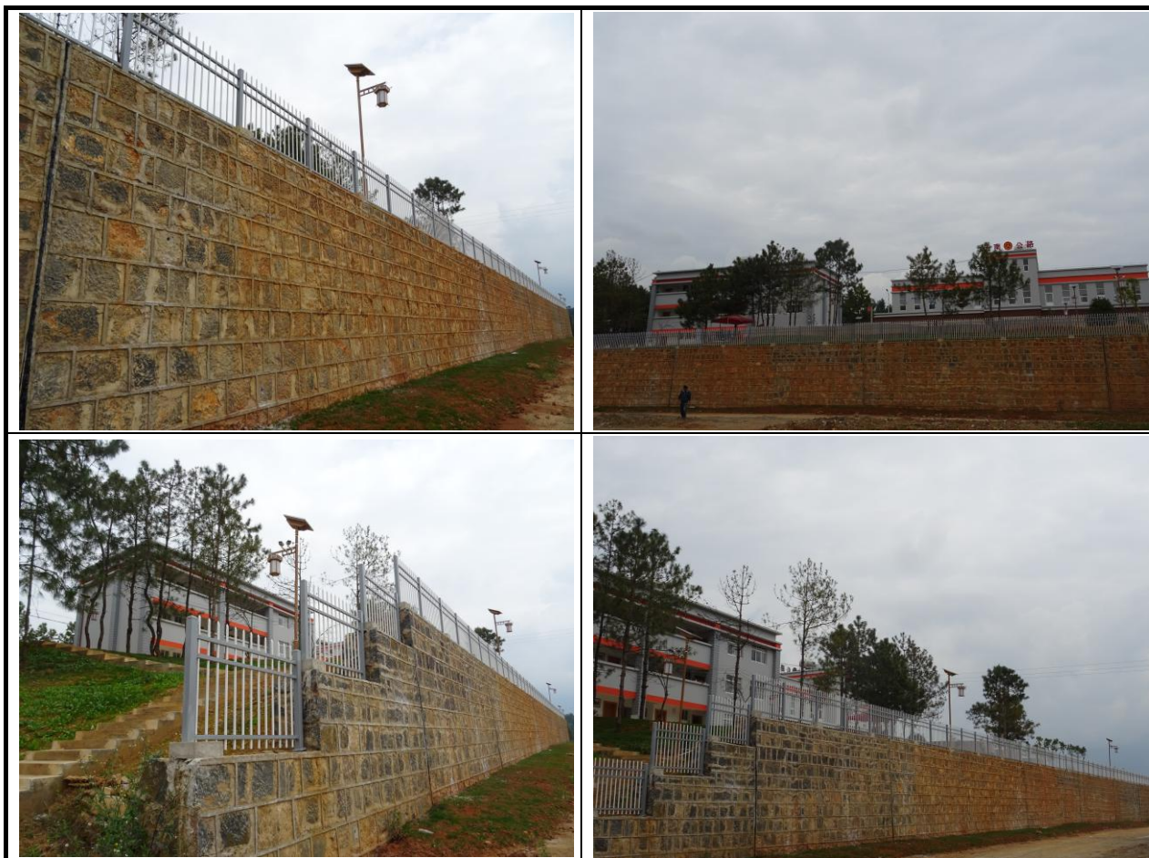
两个台阶之间浆砌石挡墙现状
