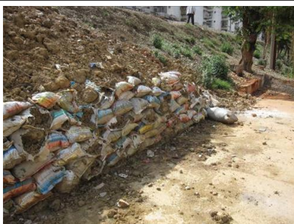
临时堆土场临时拦挡
