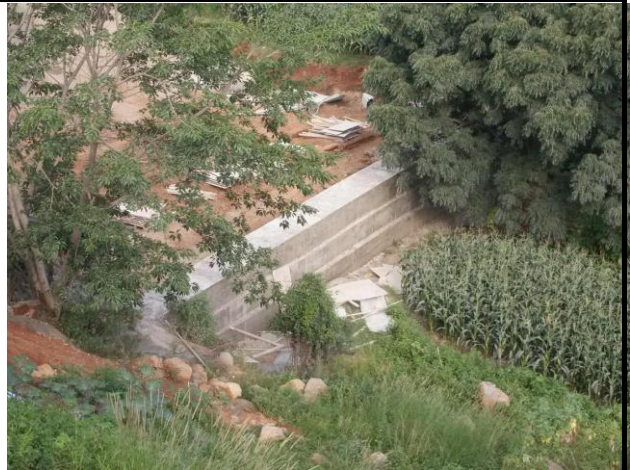
临时堆渣场下游浆砌石挡墙
