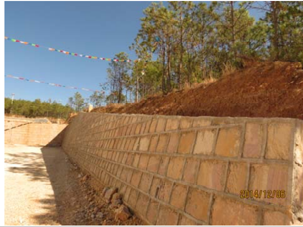
厂区东侧浆砌石挡墙建设
