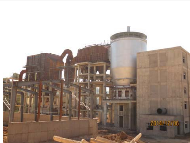
焙烧工段建设
