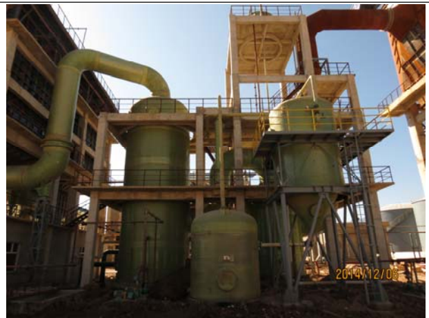
净化工段建设
