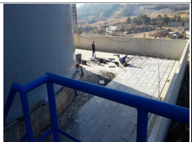
成品酸罐区建设
