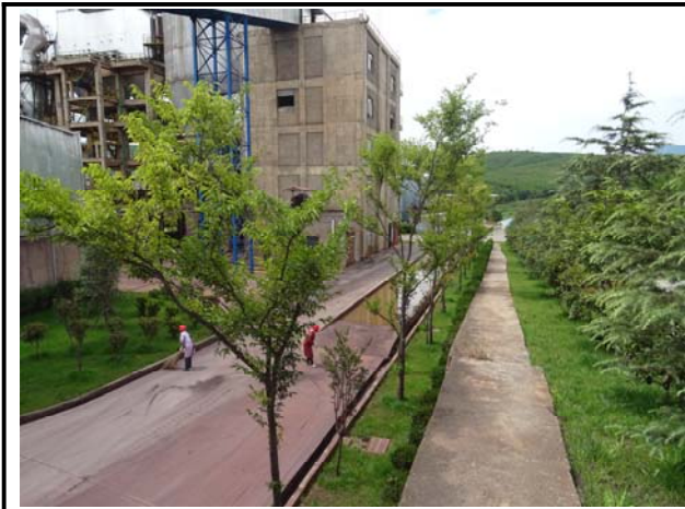
排水沟、车辆清洗池
