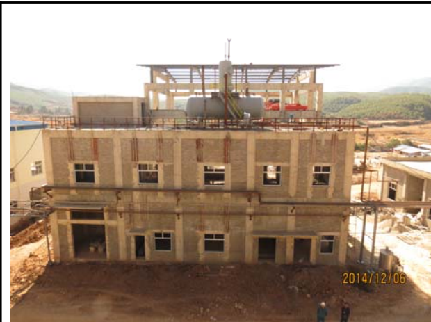
余热发电厂房建设
