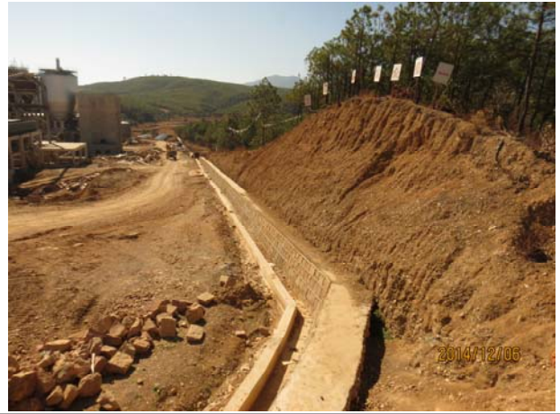
厂区西侧挡墙、截水沟建设
