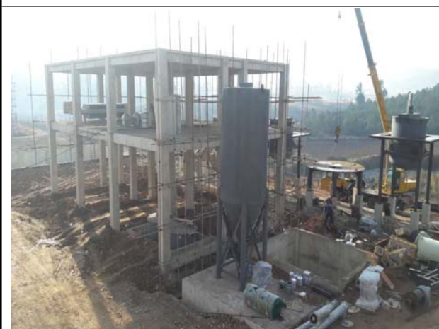
污水处理站建设
