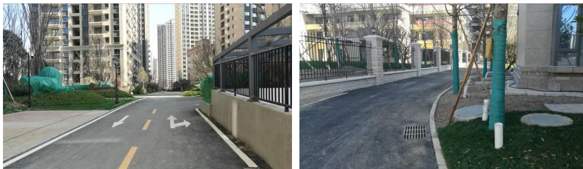
道路广场区现状
