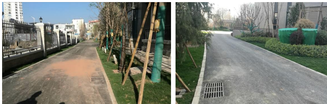
浆砌石排水沟
