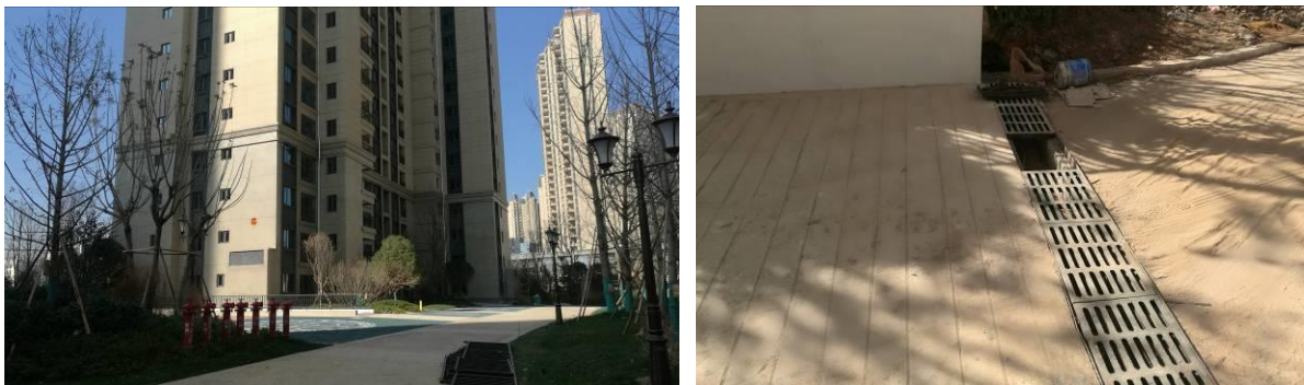
建构筑物区硬化和排水沟
