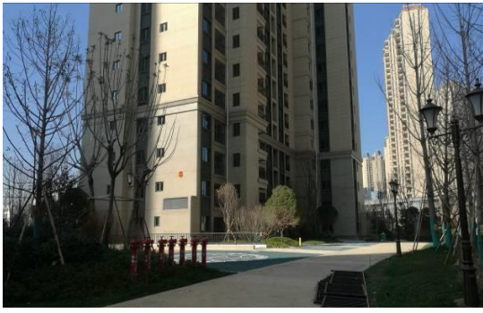
构建筑物区硬化 (1)
