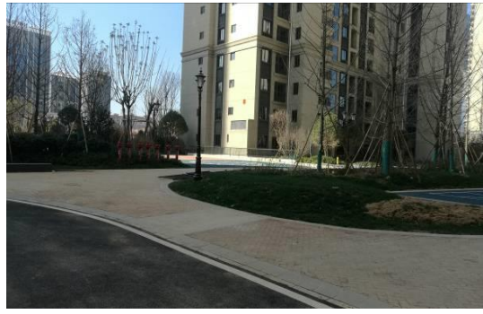
构建筑物区硬化 (2)
