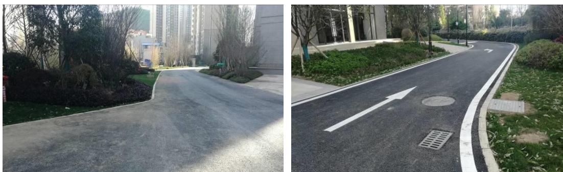
道路硬化及排水情况
