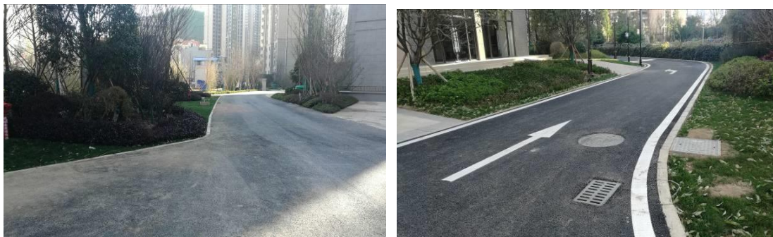
道路广场区现状
