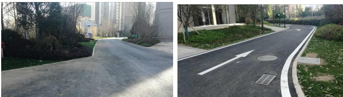
道路广场区现状
