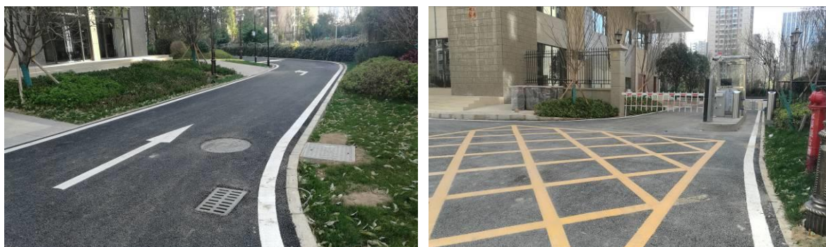
道路广场区现状
