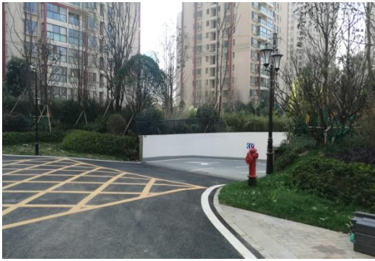
构建筑物区硬化 (1)
