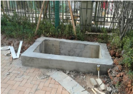
建构筑物区沉淀池
