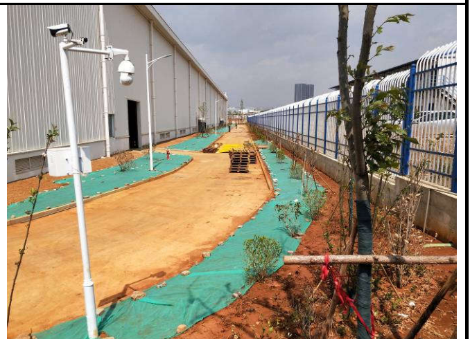
临时覆盖措施
