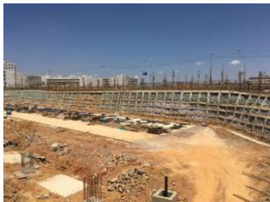
道路综合护坡 (K1+160)
