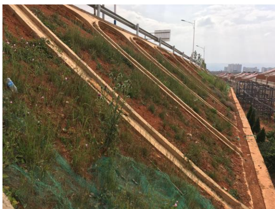
道路综合护坡 (K2+200)
