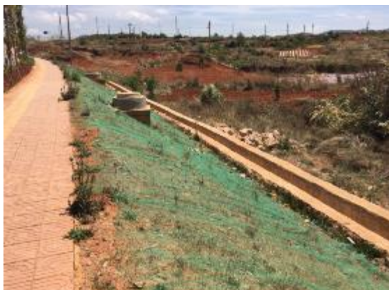
道路边坡绿化及排水沟 (K1+800)
