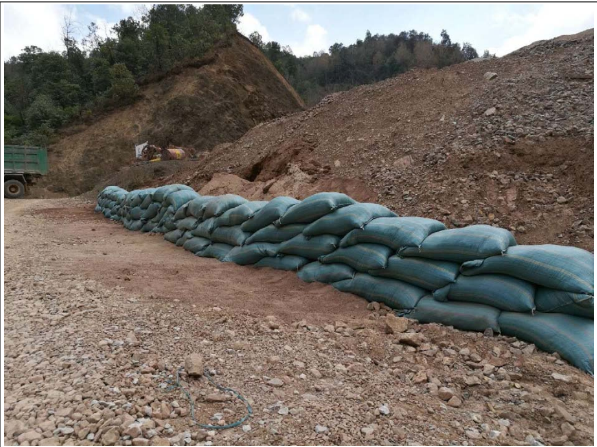
砂土袋临时拦挡（2018年3月20日摄）
