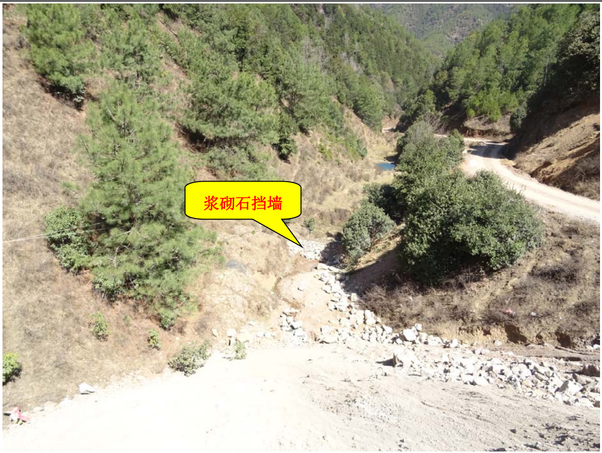
浆砌石挡墙（2018年3月20日摄）
