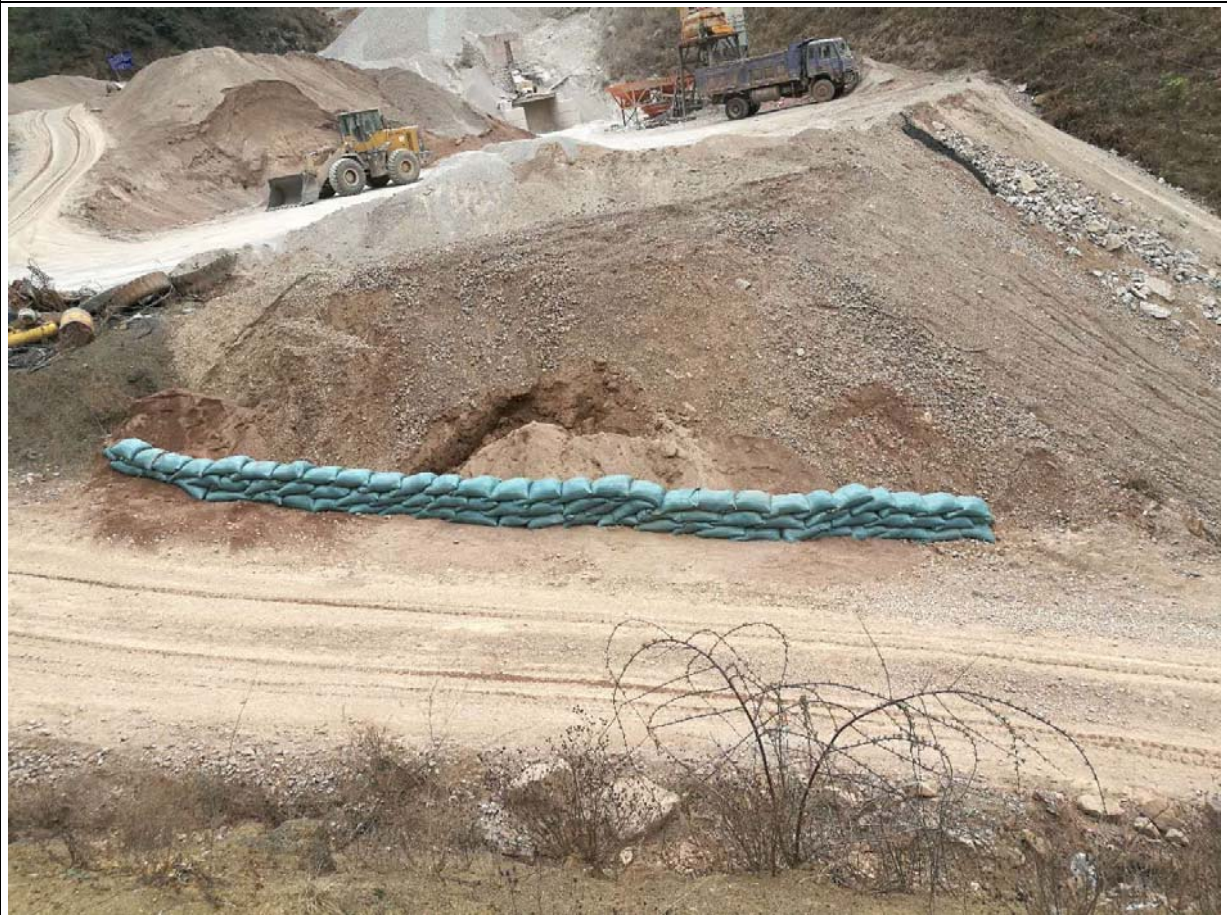
砂土袋临时拦挡（2018年3月20日摄）
