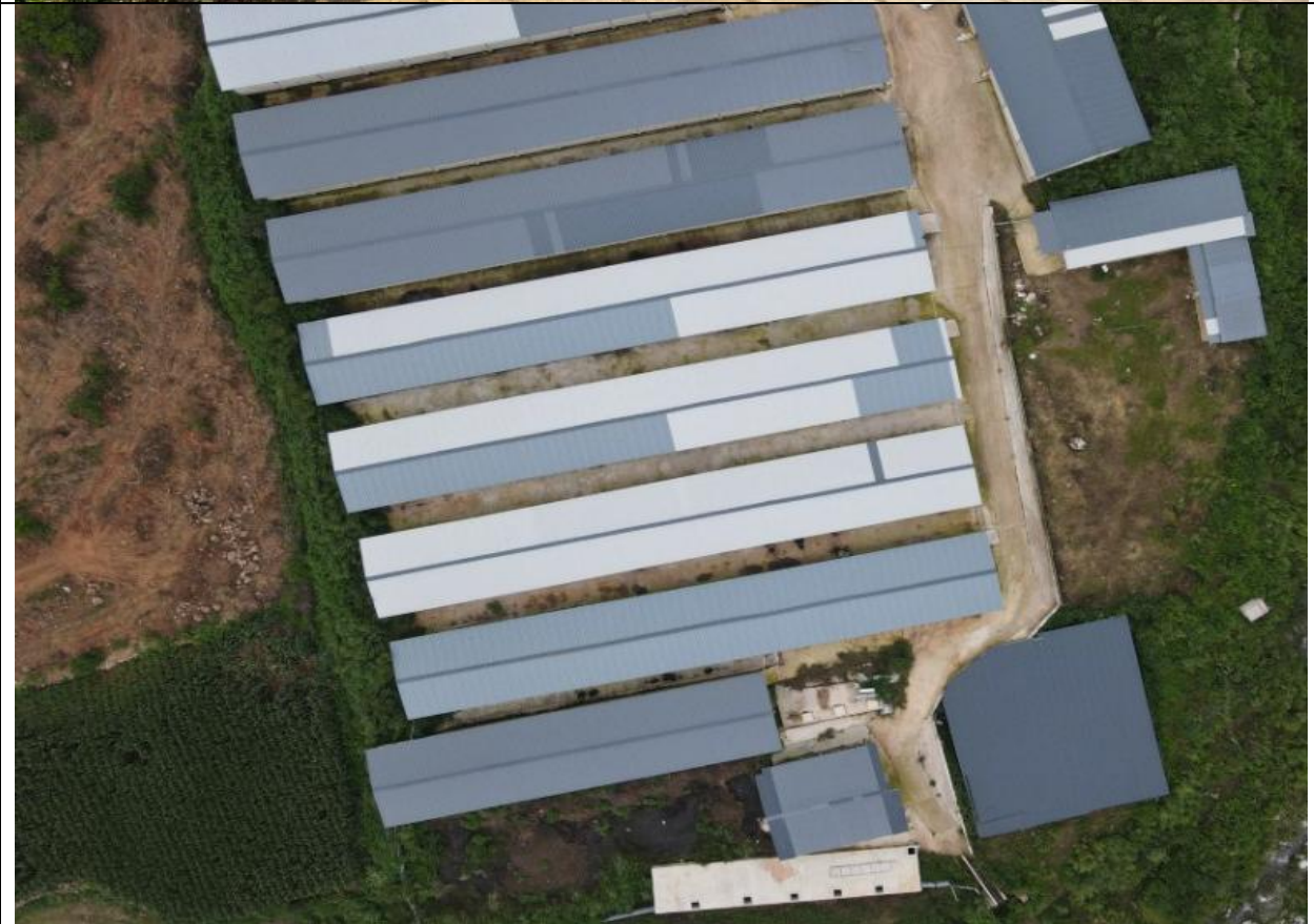
绿化区植被现状长势较好，郁闭度高，水土流失较小
